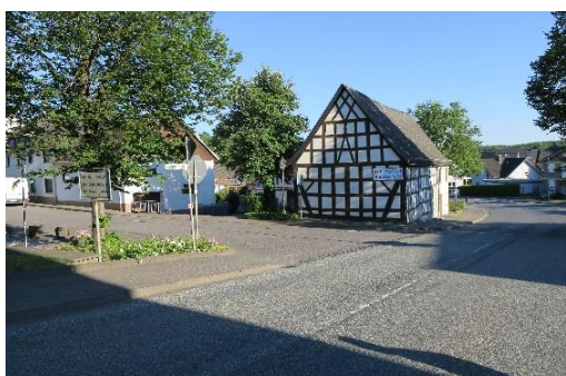
Fachwerkhaus in der Ortsmitte/Oststraße
